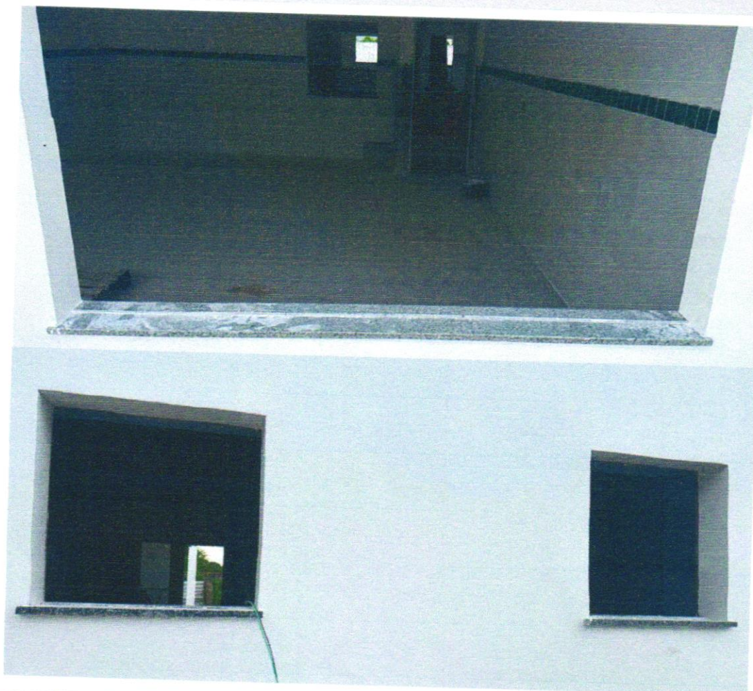
4) INSTALAÇÃO DOS PEITORIS EM GRANITO
